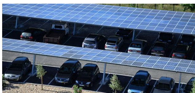
Figura 2. Exemplo de painéis fotovoltaicos integrados à arquitetura
