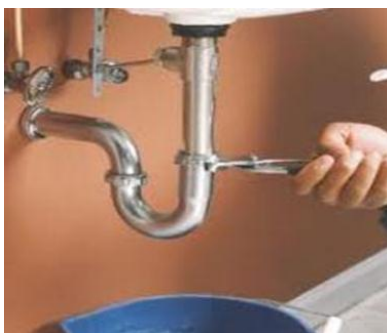
Figura 13: Manutenção de encanamento para evitar desperdícios com vazamentos
