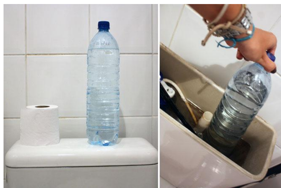
Figura 17: Colocação de garrafa pet preenchida com água para diminuição dada descarga.
