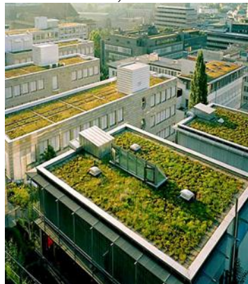
Figura 7: Cobertura de prédio com telhado verde
