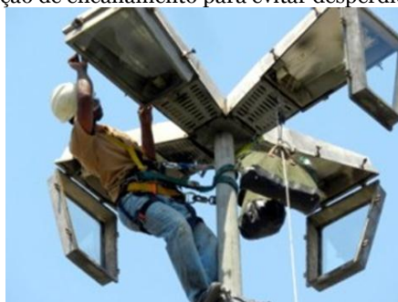
Figura 14: Manutenção de postes de iluminação para aumento da sua eficiência e para evitar-se a troca precoce de peças em razão de desgastes.
