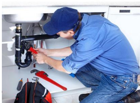
Figura 12: Manutenção de encanamento para evitar desperdícios com vazamentos
