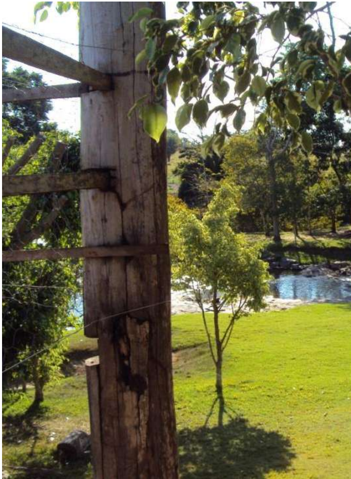
Figura 7: Sistema polonês de cerca com encaixe de madeira sem utilização de pregos
