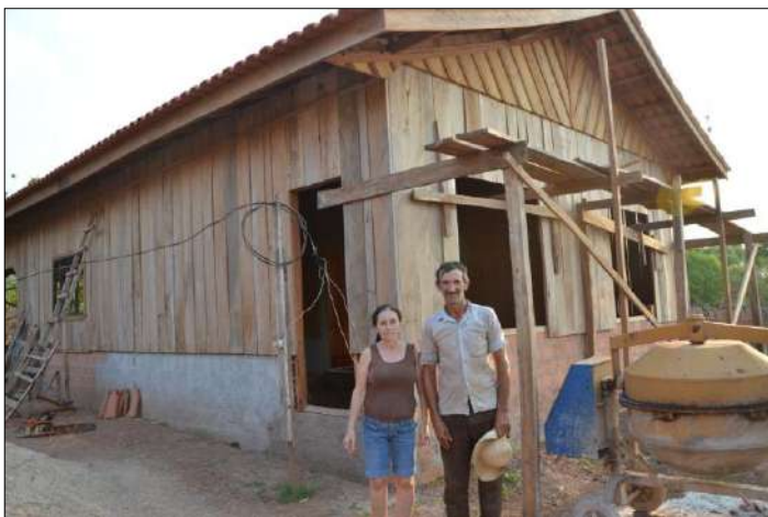
Figura 28: Vista parcial da nova casa da Família Mreglad – observa-se a parede “meia saia”
