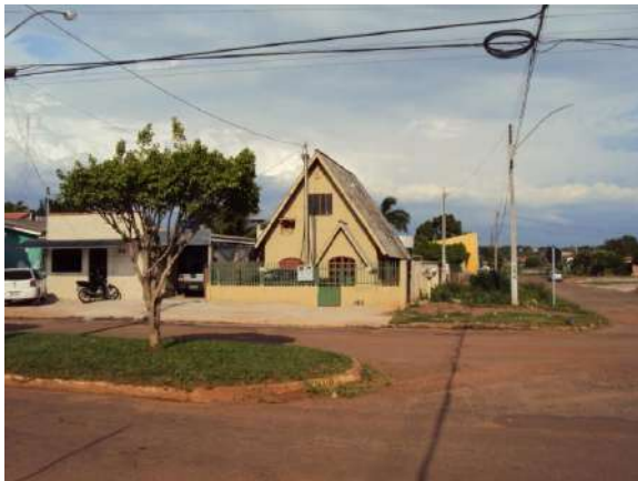
Figura 29: Chalé com cobertura de amianto em Rolim de Moura
