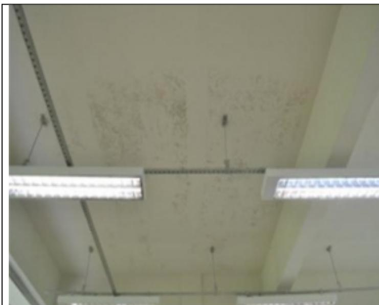
4º Ano, Técnico em Química Matutino, Bloco B. Infiltração no teto da sala de aula. Se deixada sem tratamento a infiltração pode haver maiores danos e até comprometer a estrutura do pavimento.
