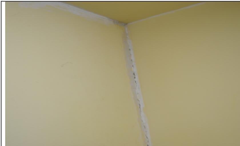
Sala 01, EaD. Fissuras na parede, comprometendo a estética da sala de aula.
